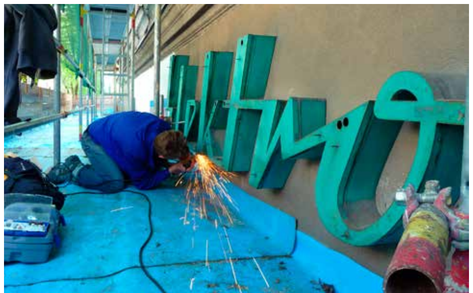
Abmontage „Elektro“ April 2012 © Stadtschrift
